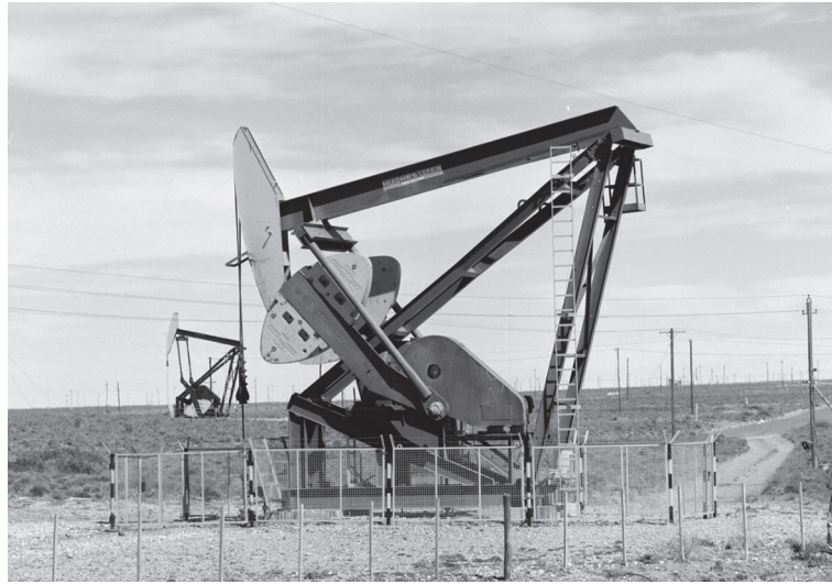
Los tradicionales "guanacos" o "ciguëñas", unidades de bombeo con las que se extrae el petróleo del subsuelo.
